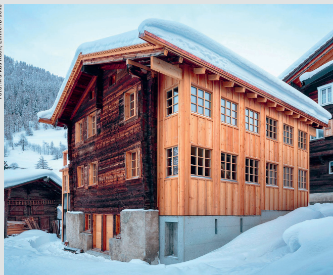
Heidenhaus Münster, Frontansicht. Planung: Roman Hutter Architektur, Luzern.
